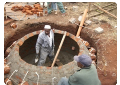
Bau von Biogasanlagen für Haushalte in Kenia
